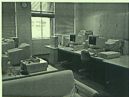
講座研究サーバー室の様子
